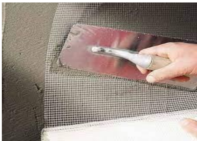
اجرا مش فایبر گلاس
