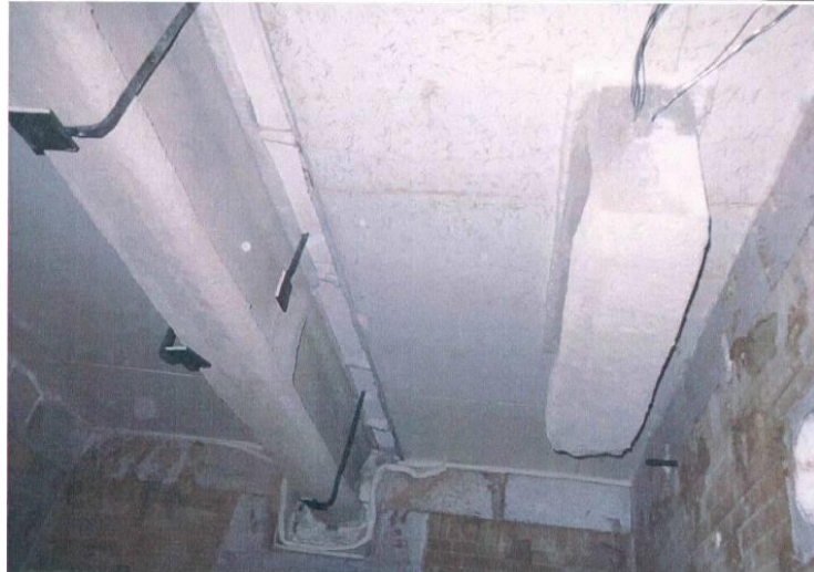
شکل ۹: آزمون حریق همزمان دو تیر فولادی محافظت شده در دو حالت با و بدون بار
